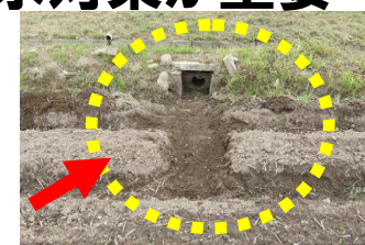
排水溝を連結し、水尻へつなげる
