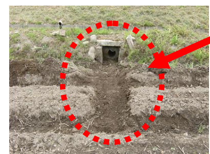
図3 排水溝の連結
