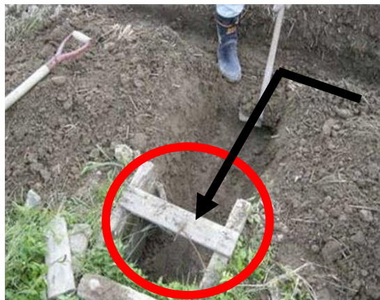
写真1 額縁排水溝から水吐尻へ 連結する作業
