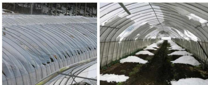
パイプハウスの骨材を守るためにハウスビニールを切断したハウス
