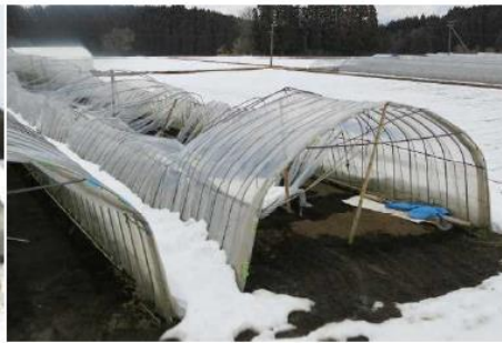
図1 中柱（つかえ棒）を設置したハウス 図2 中柱のバランスを崩して倒壊したハウス 図3 ハウスサイドの雪が溜まると落雪しなくなる
