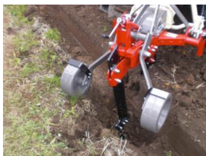
額縁明渠底面から施工
