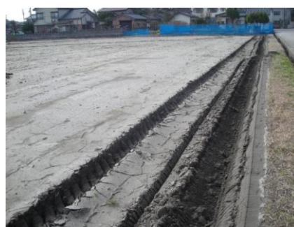
畦塗りと同時に額縁排水溝を設置 (隣接の圃場から漏水が懸念される場合は、 深めに額縁排水溝を設置する。)
