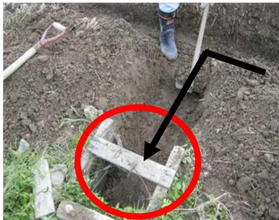
額縁排水溝から水吐尻へ連結する作業
