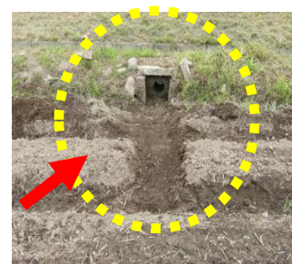
排水溝を連結し、水尻へつなげる
