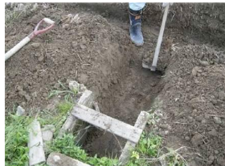
図 4 水尻の連結と掘り下げ
