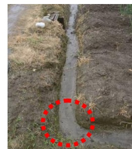
図 6 額縁排水溝の連結部を しっかりつなぐ
