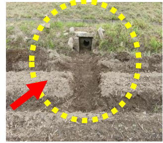
排水溝を連結し、水尻へつなげる
