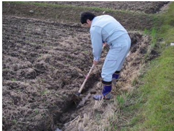
写真4 播種後、額縁排水溝に落ちた 土の除去作業
