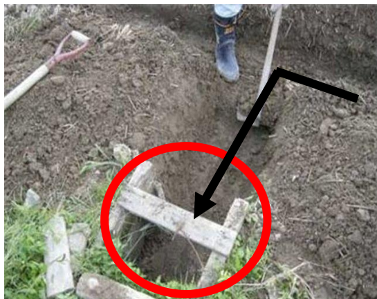
写真3 額縁排水溝から水戸尻へ 連結する作業
