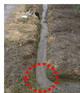
図3 額縁排水溝の連結部を しっかりつなぐ。
