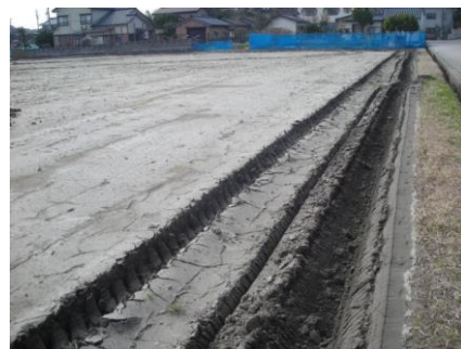
畦塗りと同時に額縁排水溝を設置 (隣接の圃場から漏水が懸念される場合は、 深めに額縁排水溝を設置する。)
