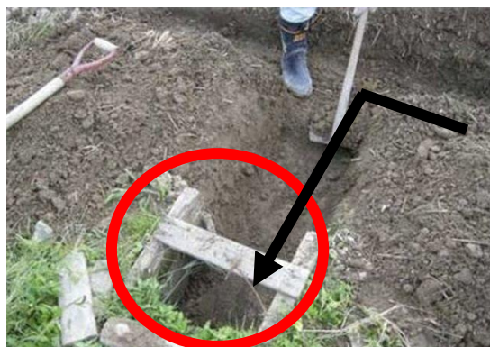
写真3 額縁排水溝から水尻へ連結する作業
