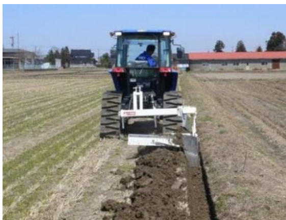
写真1 稲刈り後すぐに額縁排水溝を設置
