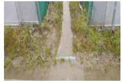
写真3 ハウス周辺の排水対策
