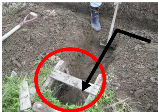
写真3 額縁排水溝から排水口へ連結する作業
